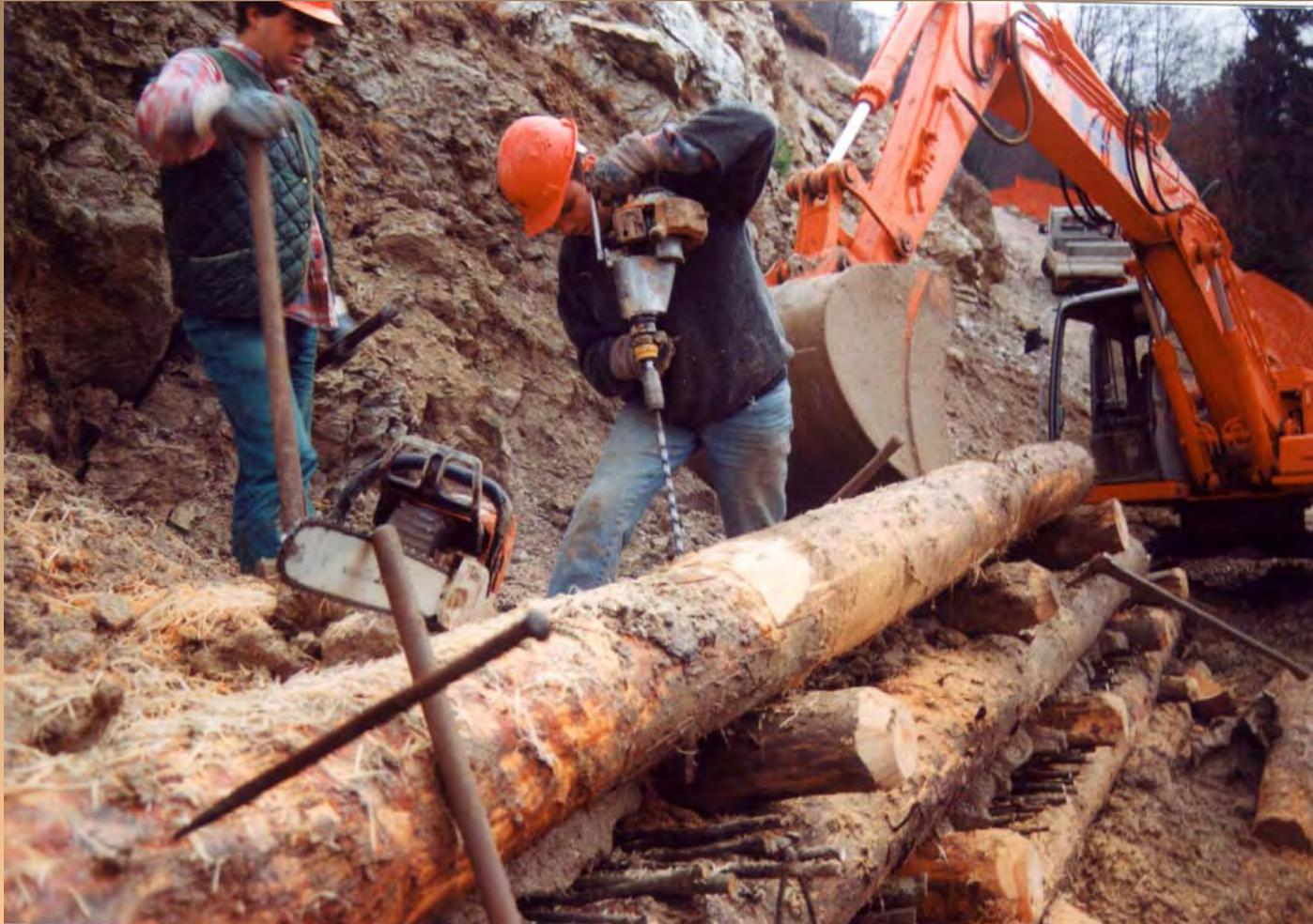
**Palificata viva doppia in costruzione. Fase di predisposizione dei fori per l'infissione delle chiodature.**
