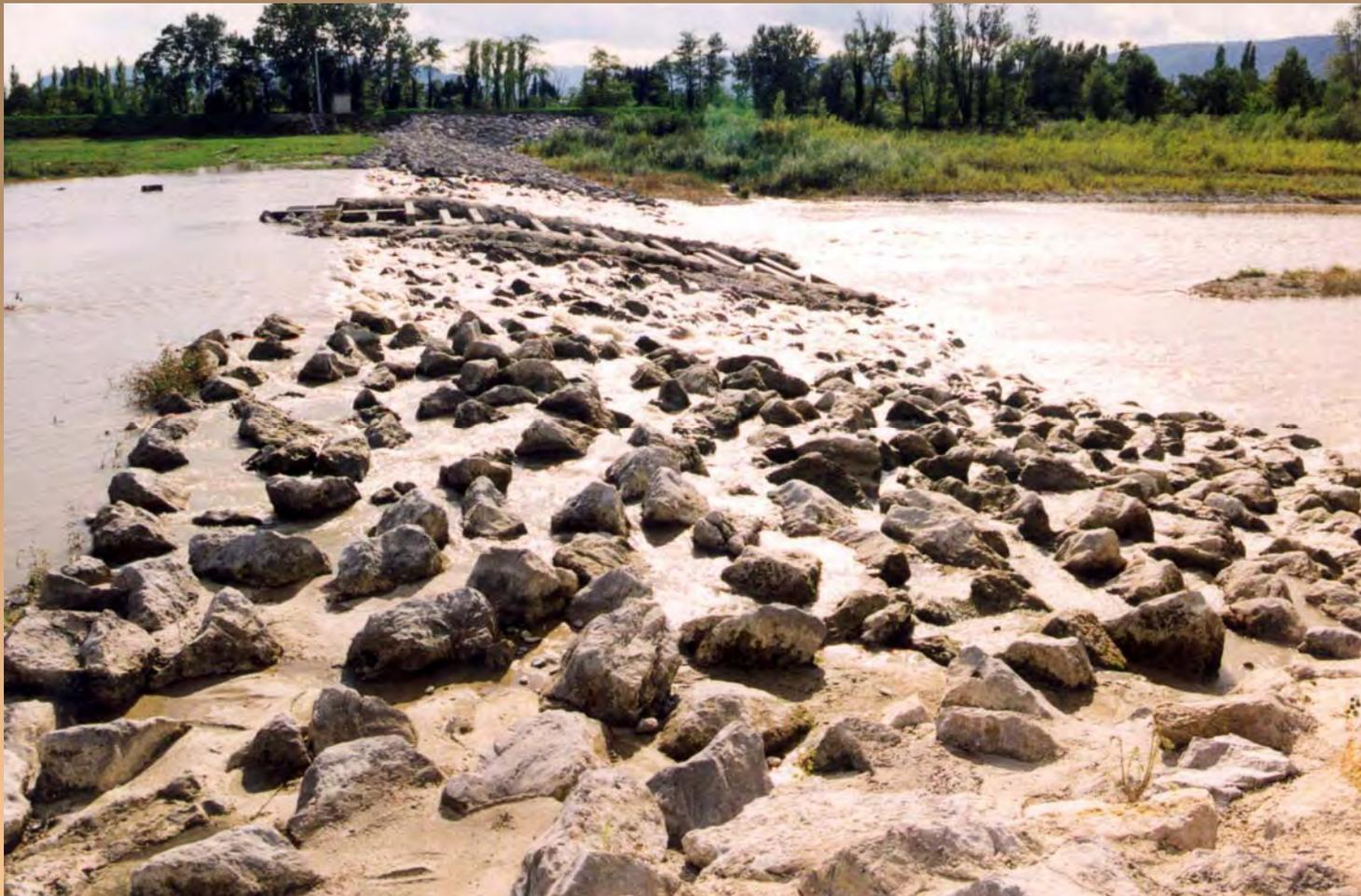
**Rampa a blocchi in massi cementati e scale di rimonta per ittiofauna. Affluente F. Rodano (Francia)- Foto G. Sauli**
